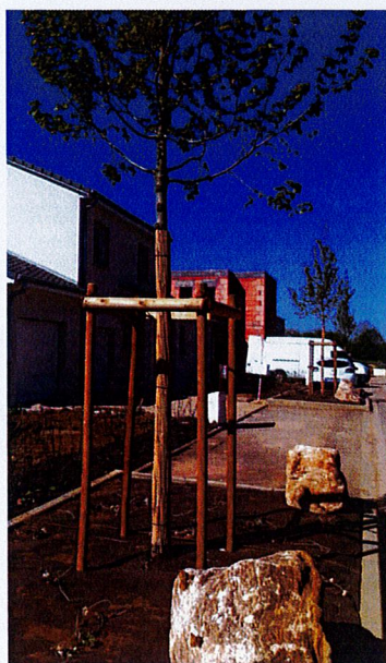
Exemple de tuteurage quadripode pour arbres tige (4 tuteurs + 1 lisse en partie haute)
