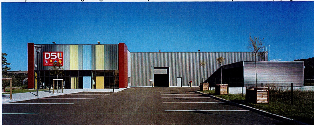
Exemple de bâtiment présentant de meilleures qualités d'intégration urbaines.
